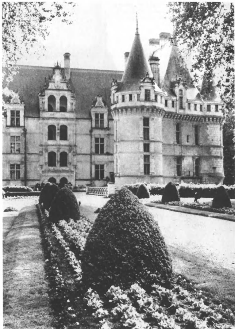
Замок Азе-ле-Ридо. Вид со стороны парка.
