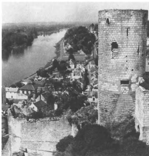
Замок Шинон. Башня Мулен и вид на город.
