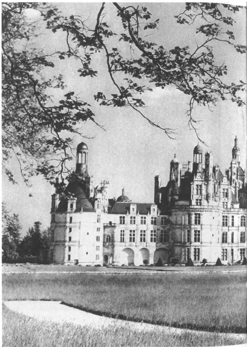
Замок Шамбор. Общий вид.
